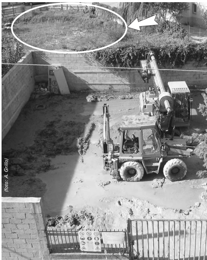
Ottobre 2005, Via Udine, lavori in corso a ridosso della depressione (indicata dal cerchio) causata dallo sprofondamento del 2002.
