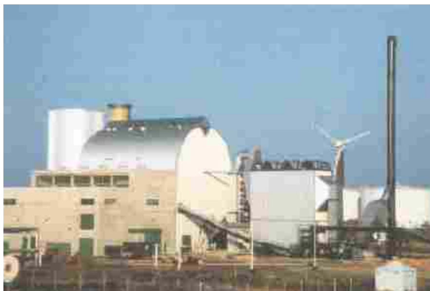
Fig. V.25. Esempio di impianto alimentato a paglia realizzato in Danimarca.
